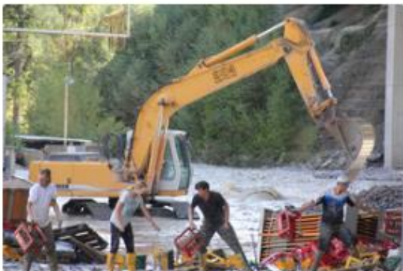
Bei den Aufräumarbeiten im Gewerbegebiet Grins/Graf ist vor allem Körper-Einsatz gefragt. Der Bagger räumt das Flussbett der Sanna.
