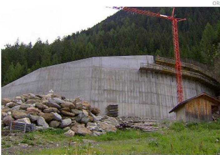
Die neu errichtete Geschiebesperre
